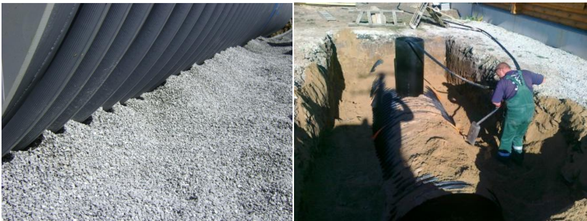
شکل ۴: نمونه ای از پر کردن اطراف مخزن
