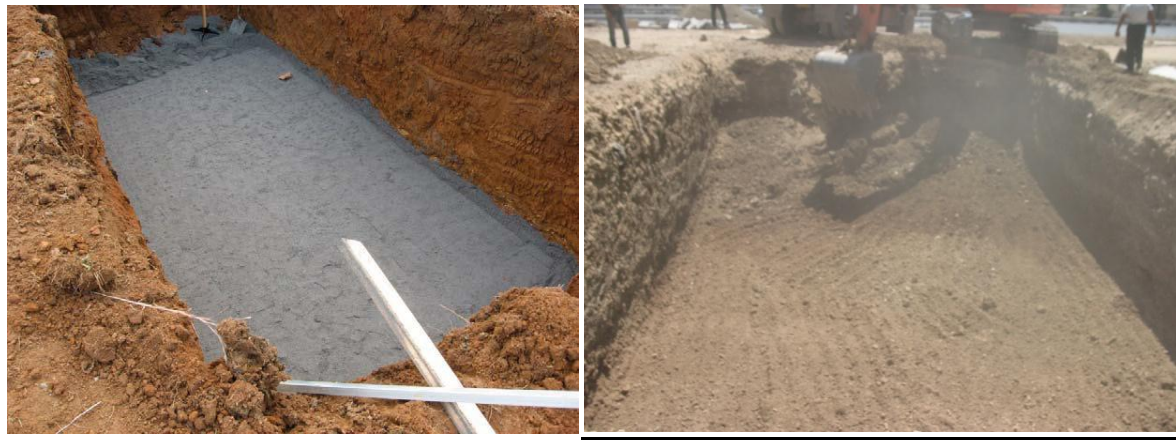
شکل ۱: نمونه هایی از آماده سازی کف چاله
